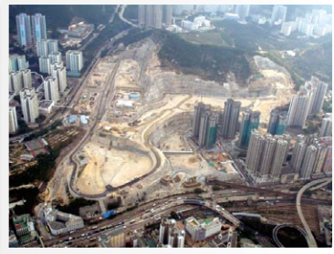
圖9-20. 佐敦谷土地平整工程。 Figure 9-20. The Jordan Valley site formation.
