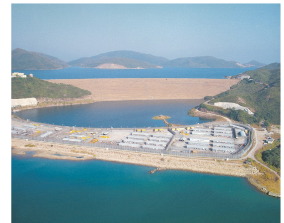
圖13. 萬宜水庫西壩。 Figure 13. The High Island West Dam.
