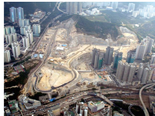
圖10. 佐敦谷土地平整工程。 Figure 10. The Jordan Valley site formation.
