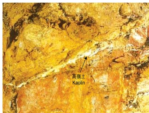
圖B-5. 風化凝灰岩中的節理填入高嶺土。
