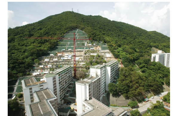
圖21. 在政府斜坡上進行防止山泥傾瀉工程。 Figure 21. Landslip preventive works on a government slope.
